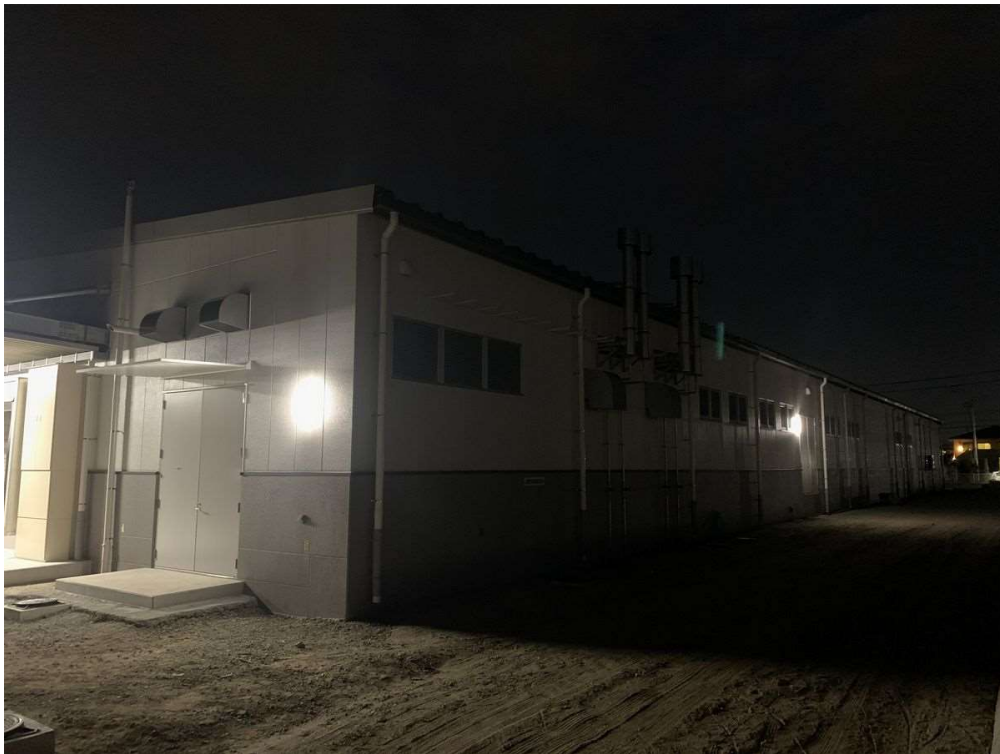
完成 (夜間) 外部 南側
