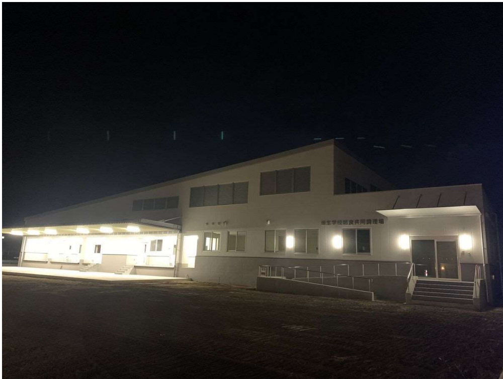
完成 (夜間) 外部 東側
