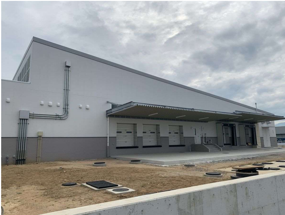
完成 (昼間) 外部 西側
